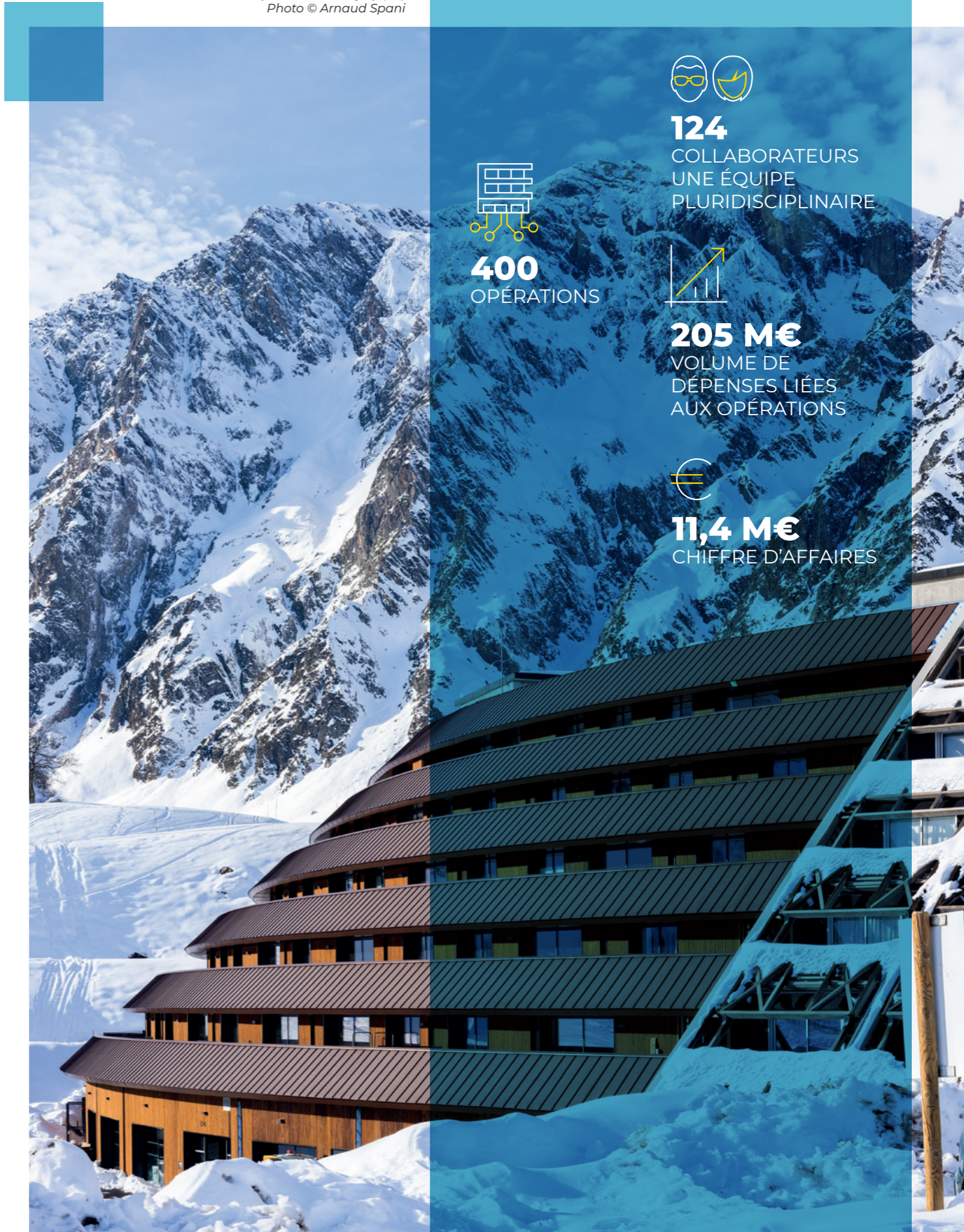
Construction de la résidence de tourisme Crystal à Piau Engaly (65) Photo © Arnaud Spani
