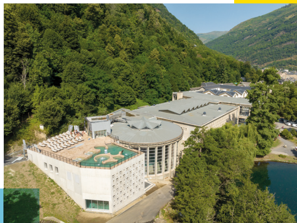
Réhabilitation et extension des Thermes de Luchon (31)
